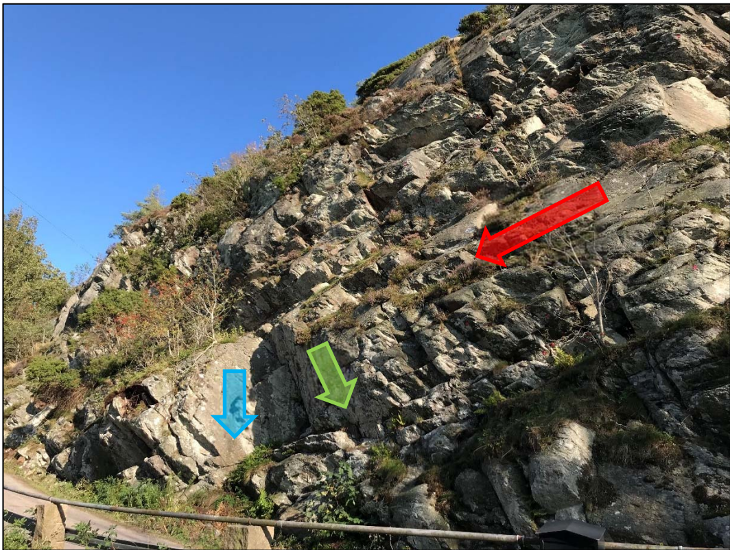
Bild 1. Tre dominerande sprickriktningar i berget skapar potentiellt lösa block.
