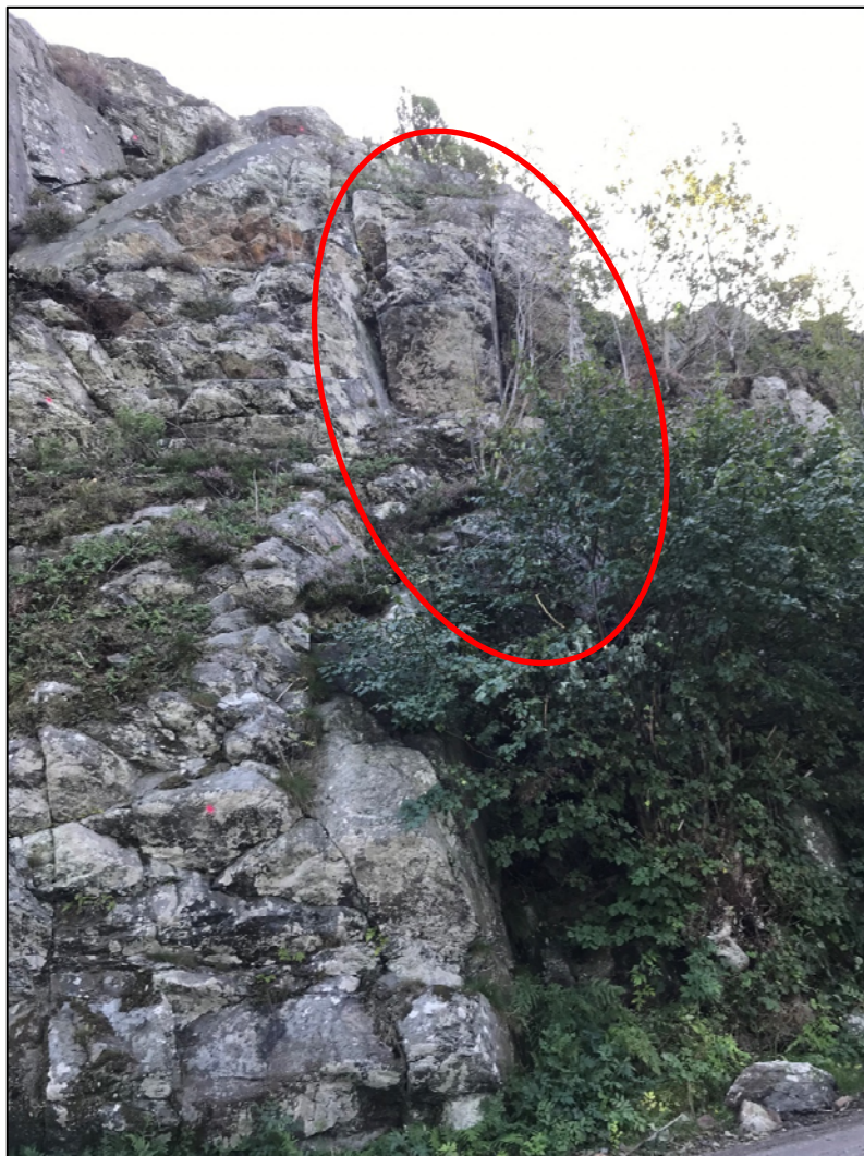
Bild 5. Bergsparti med flera potentiellt lösa block.
