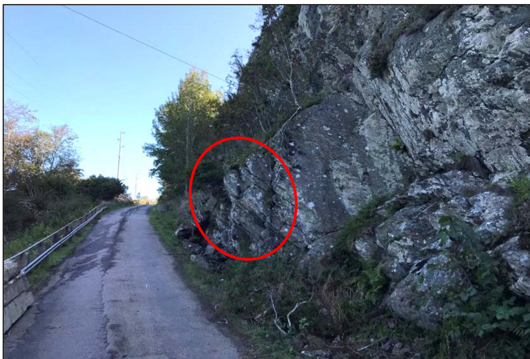
Bild 4. Överhäng i bergslänten intill Instölid bör säkras med bergbult.
