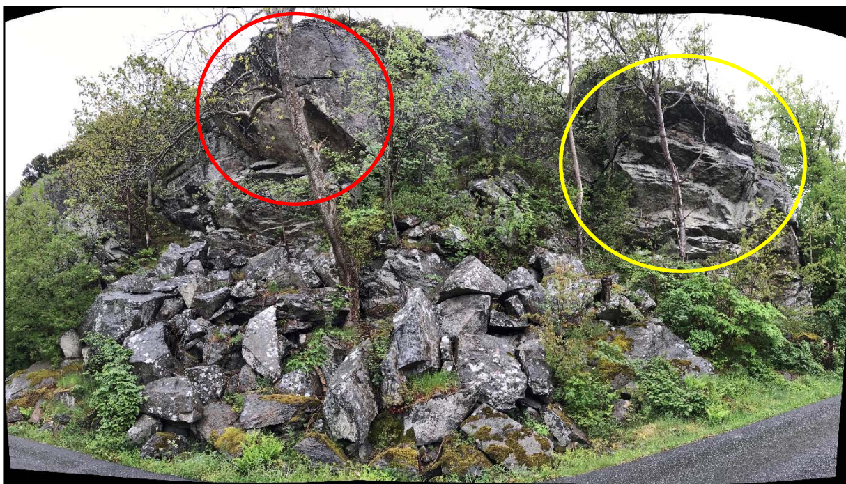
Bild 2. Överhäng i berget intill Tjällviksvägen.
